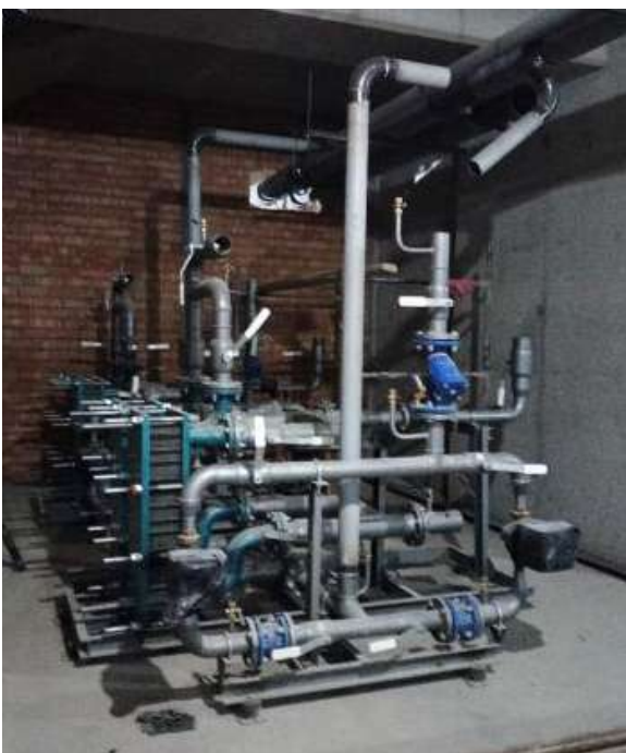
Блочно-тепловой пункт Узбекистан, г. Ташкент ЖК U-Tower
