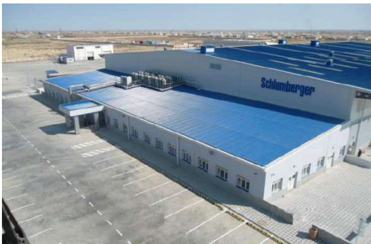
Котельная для производственной базы «Shumberger» Мангистауская область
